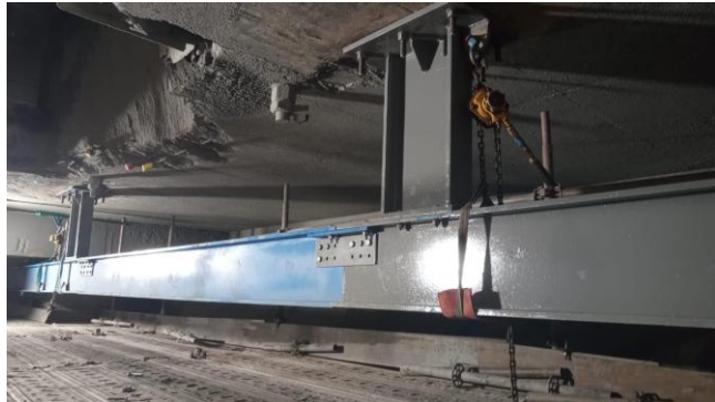
a) Viga metálica fixada em laje de concreto armado
