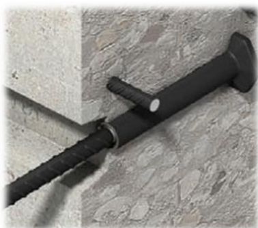
b) Ligações entre painéis pré-moldados de concreto
