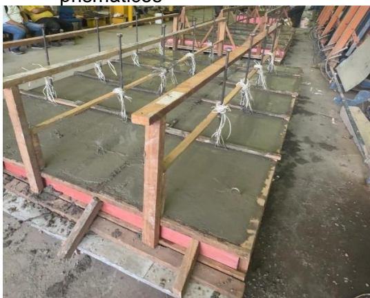
c) Peças após a concretagem
