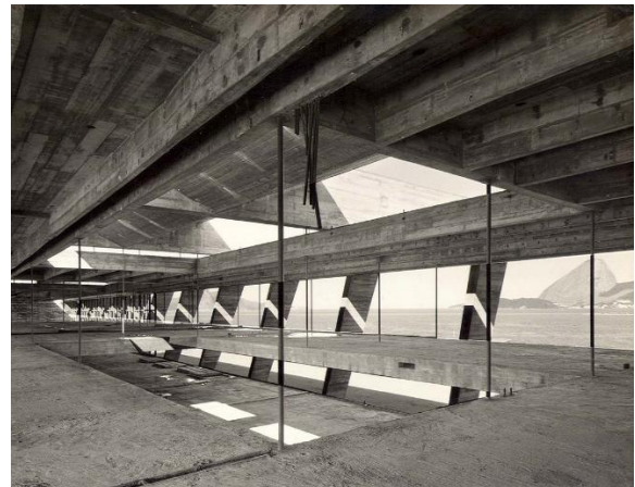
b) Tirantes metálicos conectando mezanino a vigas mestras de concreto armado
