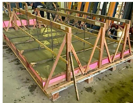
c) Peças após a concretagem
