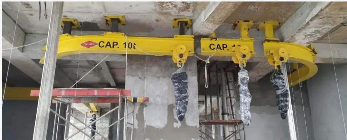
b) Monovia metálica embutida em laje de concreto armado, disponível https://www.truckfort.ind.br/
